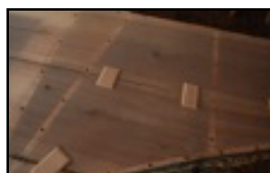
Plaques modernes de renforcement du fond (épicéa)
